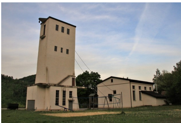
Na Reštanju še stoji strojnica in stolp rudniškega dvigala senovskega rudnika
